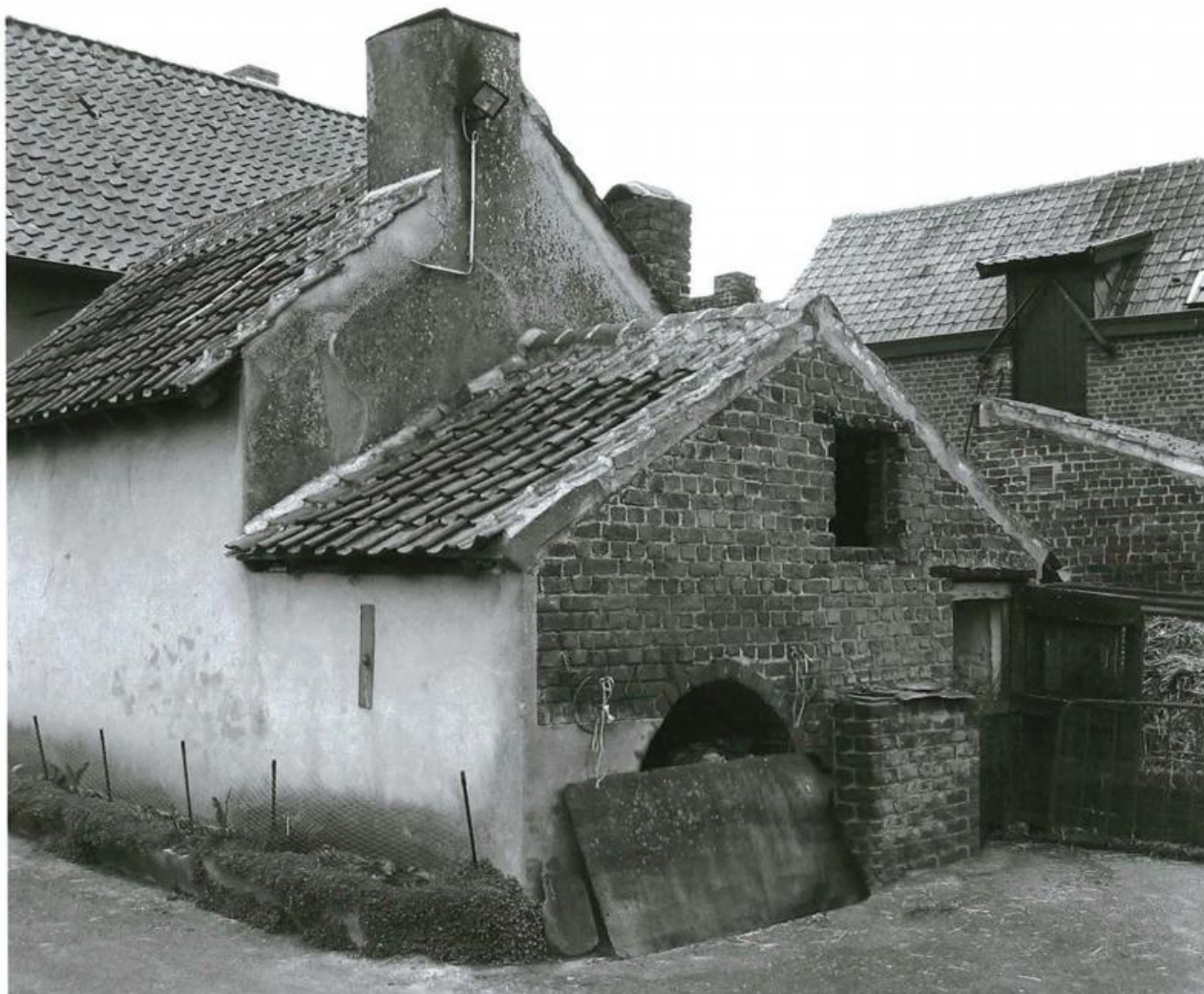
Een opening onder de oven diende als bergplaats voor "atsels" (takkenbos). Kerkstraat 101, Dworp, anno 2007.
