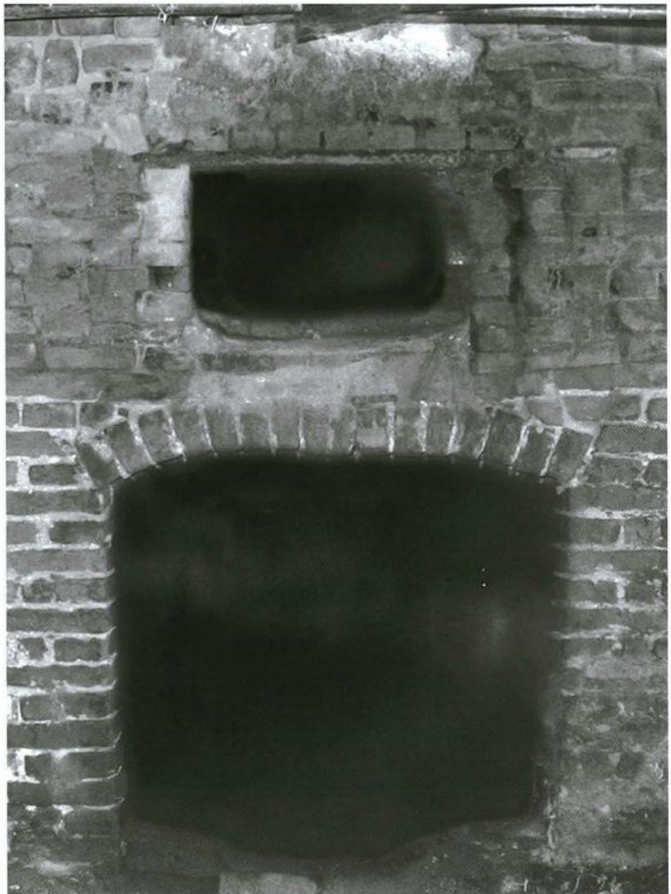
Bovenaan de ovenmond en onderaan de ruimte voor het stapelen van het brandhout. Nerem 1, Lot, anno 2007.
