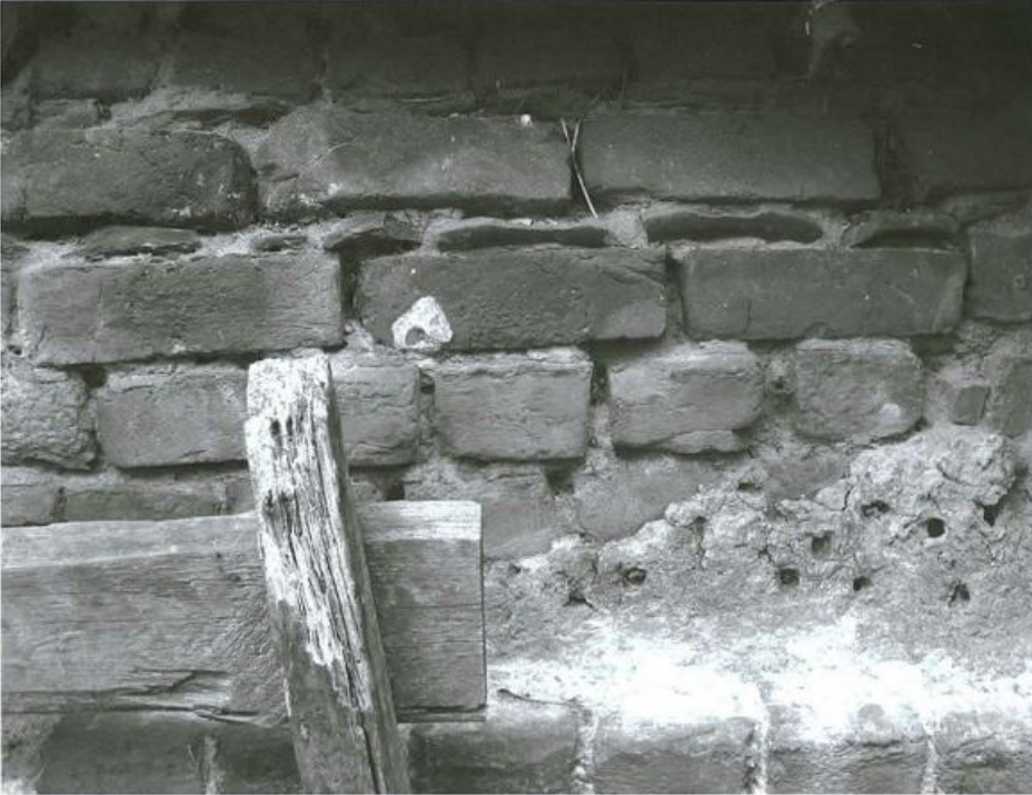
Het bakstenen ovengewelf was langs de buitenzijde bedekt met een leemlaag. Grootheide 37, Dworp, anno 2007.
