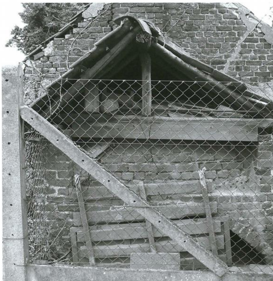
Het dakgebinte van de oven rustte op de stenen onderbouw. Grootheide 37, Dworp, anno 2007.
