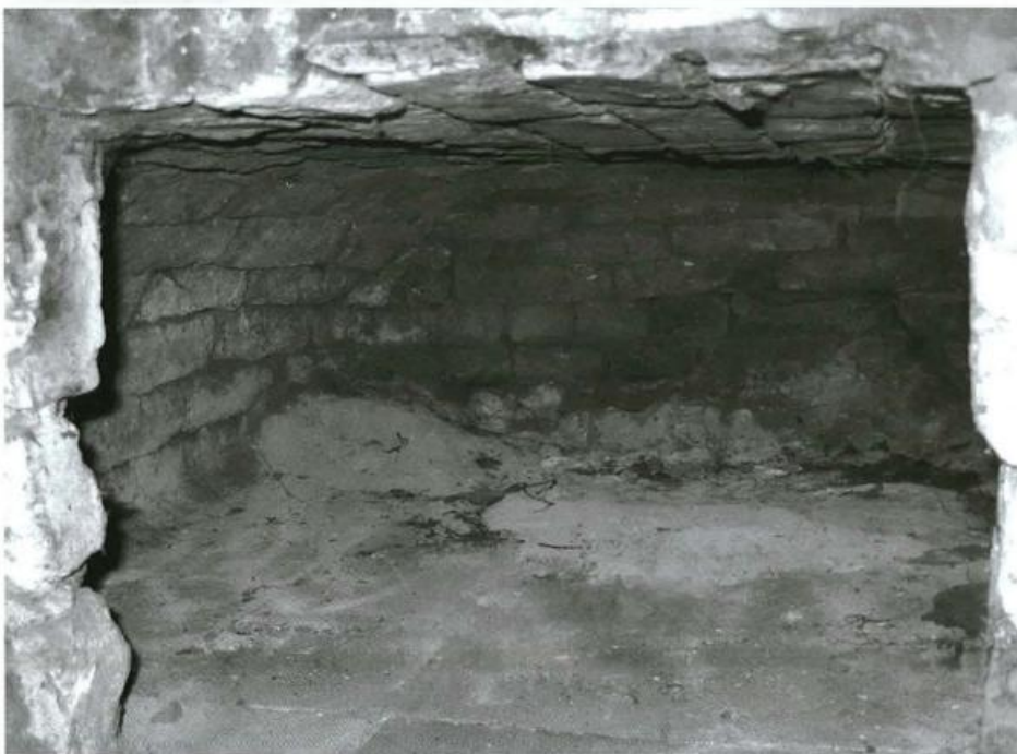
Langs de ovenmond werden de bussels kaphout (brandstof) en het brood naar binnen geschoven. De ovenvloer bestond uit vuurvaste tegels. Herisemweg 20, Elsemheide Alseberg, foto anno 2007.
